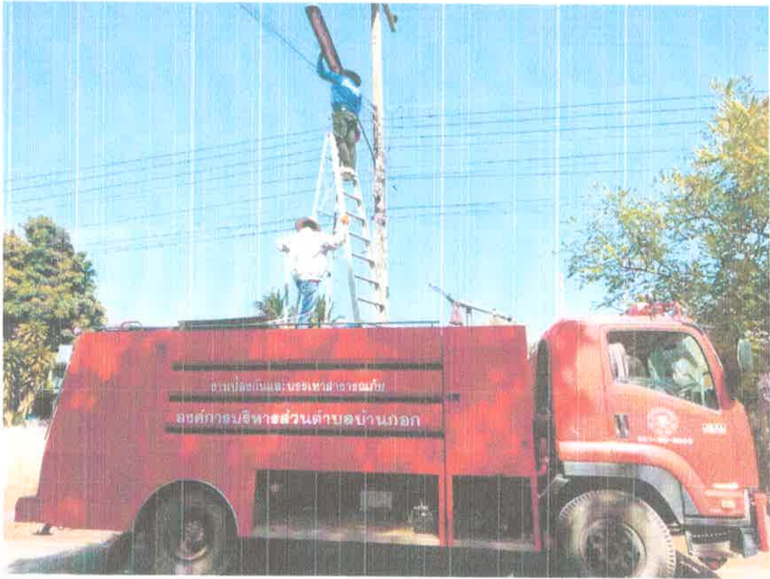
ซ่อมแซมไฟฟ้าสาธารณะบ้านสระสีเหลี่ยม หมู่ ๗
