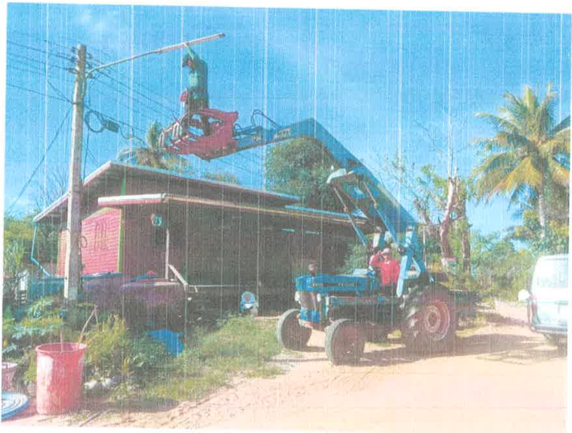
ซ่อมแซมไฟฟ้าสาธารณะบ้านหนองไผ่ หมู่ที่ ๑๕
