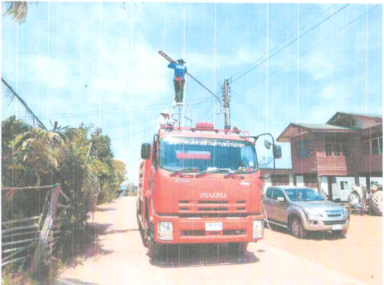
ซ่อมแซมไฟฟ้าสาธารณะบ้านสระสีเหลี่ยม หมู่ ๗
