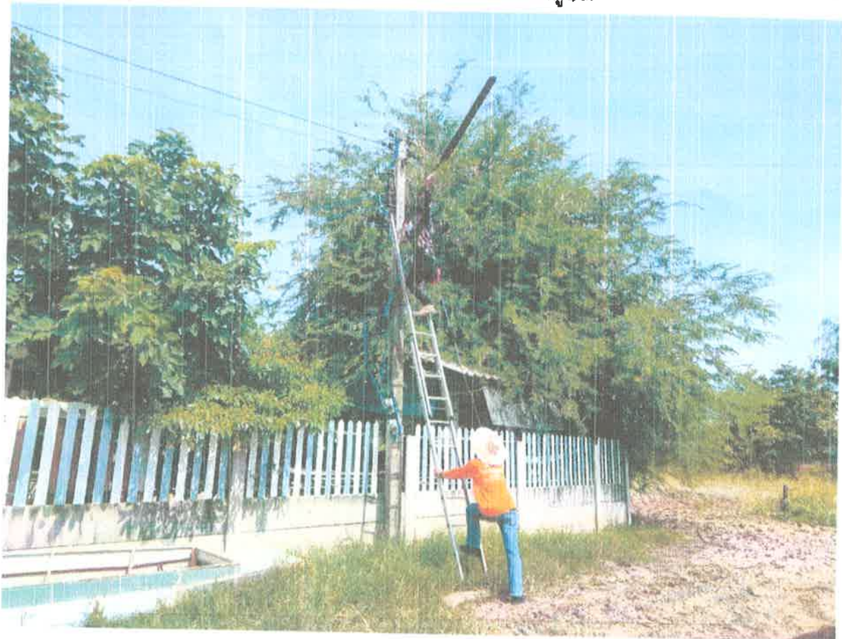
ซ่อมไฟฟ้าสาธารณะบ้านมะเกลือ หมู่ ๑๓
